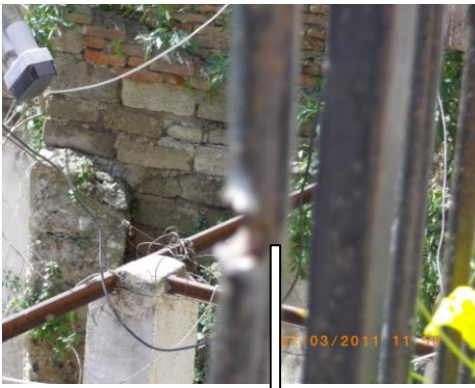
Barreau sectionné par un tir de gros calibre
